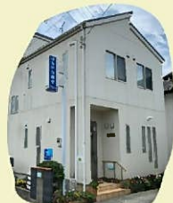
駐車場は入口のすぐ前
